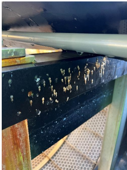
lus på vegg selv etter vask og desinfeksjon
